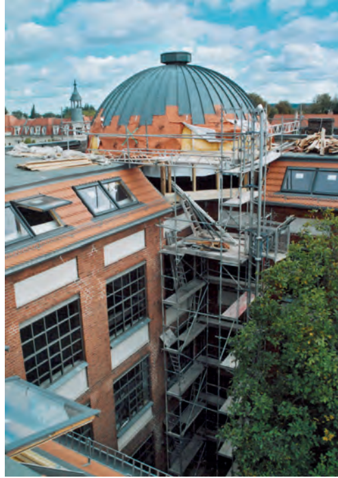
Bau und aufgesetzte Kuppel für das Planetarium 2006
