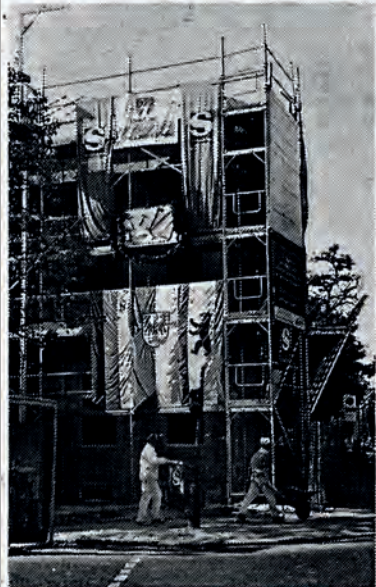
RICHTFEST. In der Charlottenstraße saniert die Potsdamer Filiale der Berliner Bank ein denkmalgeschütztes Haus. Zweifellos ein Beispiel „behutsamer“ Stadterneuerung. Foto: Dietmar Horn
