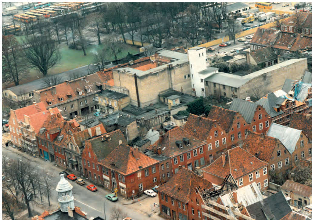
84 Luftbild Häuser und nordöstlicher Bassinplatz 1991
